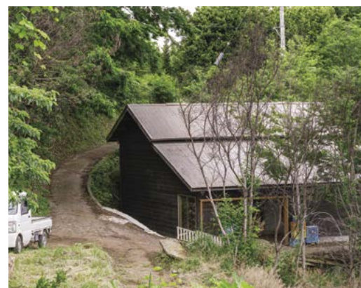
リフォーム中の蔵は管理棟として活用予定
