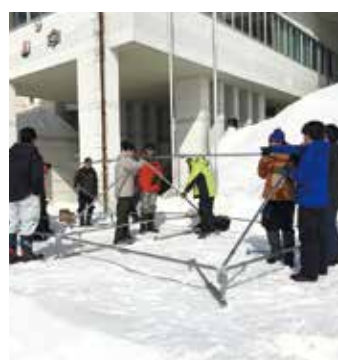
祭りのためにテントを組み立て中
